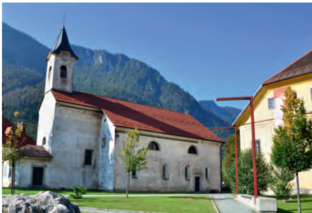
Cerkev Marijinega vnebovzetja iz začetka 17. stoletja na Stari Savi / Church of the Assumption located in Stara Sava and dating from the beginning of the 17th century / Die Mariä-Himmelfahrt-Kirche von Anfang des 17. Jahrhunderts in der Ortschaft Stara Sava / La Chiesa dell'assunzione della beata Vergine Maria dall'inizio del 17 secolo a Stara Sava
